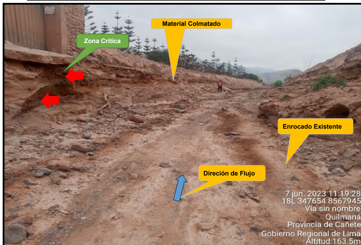
FIGURA N°05: SE MUESTRA LA SOCAVACION QUE PRODUCE EL RIO IHUANCO EN AVENIDAS DE HUAYCO
